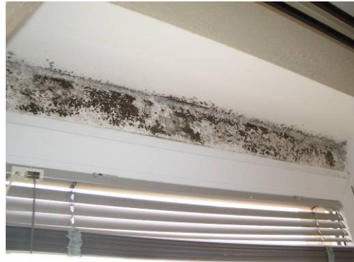
Abb.5 Schimmel auf einer Wärme- und Kältebrücke (M. Tomšič)
