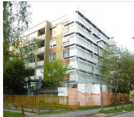
Abb.6: Anbringung einer Wärmedämmung im Rahmen einer Gebäudesanierung (M. Skubic)
