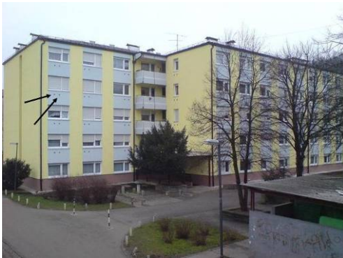
Abb.16 Foto eines Gebäudes aus den 70er Jahren nach der Sanierung, in der die Fenster ersetzt und eine Wärmedämmung aufgebracht wurde. Sichtbar sind einzelne, automatische Belüftungsein- und Austritte die mit dem Wärmerückgewinnungssystem gekoppelt sind (M. Skubic)
