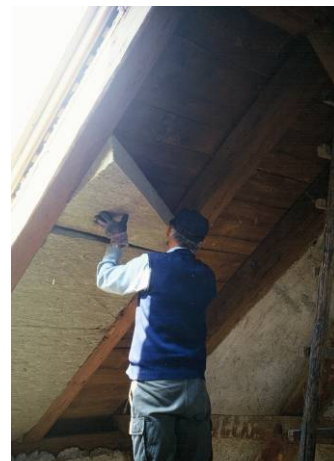
Abb.11: Dämmung eines Daches (M. Tomšič)
