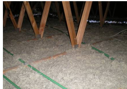
Abb. 9: In Deckenisolierung eingblasener Rockwool-Dämmstoff.
