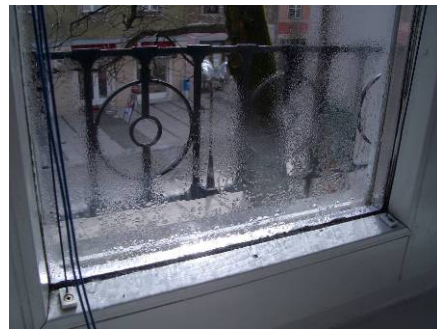
Abb.15: Kondensationsspuren auf einer Fensterinnenseite, herbeigeführt durch eine zu hohe Raumfeuchtigkeit. (M. Tomšič)
