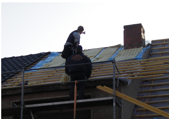
Abb.10: Arbeiter beim Aufbringen einer Wärmedämmung (B. Schulz)
